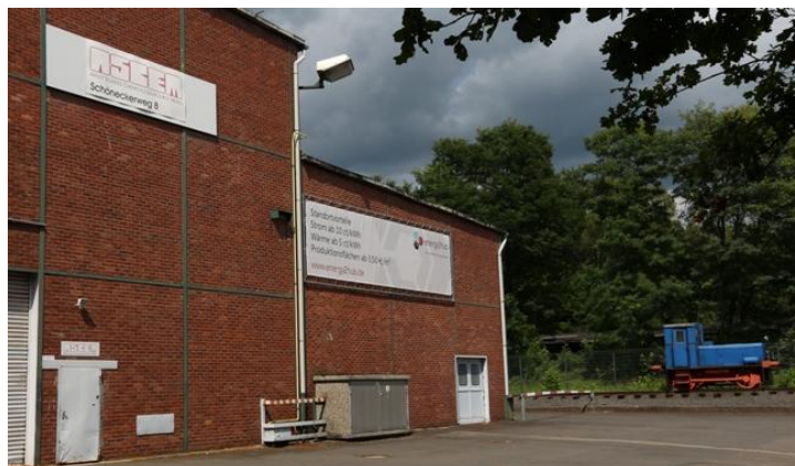
Industriehalle der ASCEM GmbH in Schladern
